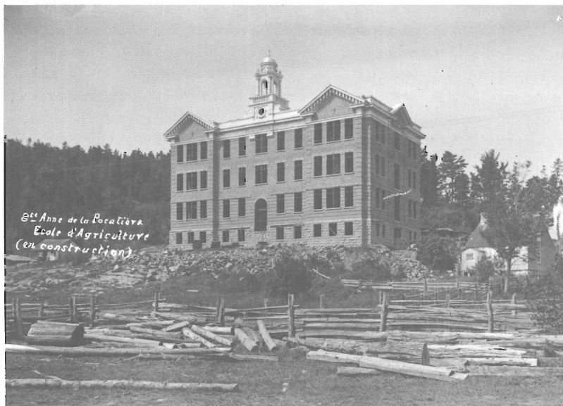
Construction de la nouvelle École d'agriculture en 1912 (fonds J.B. Dupuis no 473, musée du Bas-Saint-Laurent)
