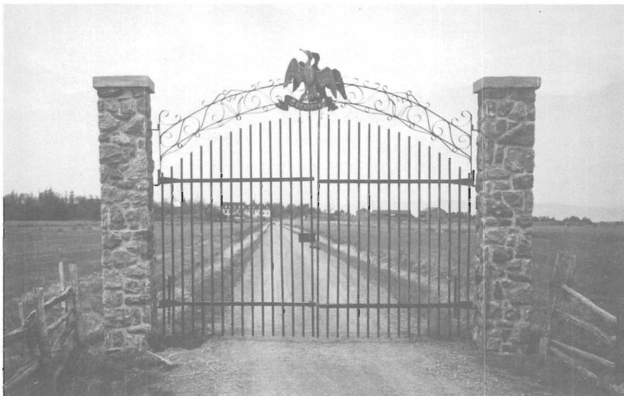
Route d'accès au site de l'ancien manoir Taché (Paul Larocque)
