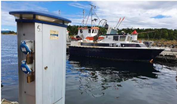
(a) : Borne de recharge lente en AC [54]
