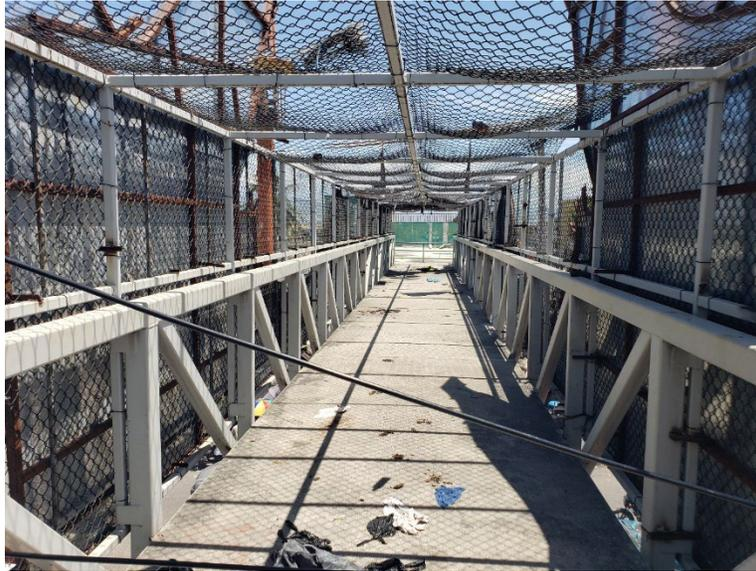
Figure 20 - Passerelle située sur la route de Delmas. Cette photo met en évidence l'insalubrité de la passerelle.
