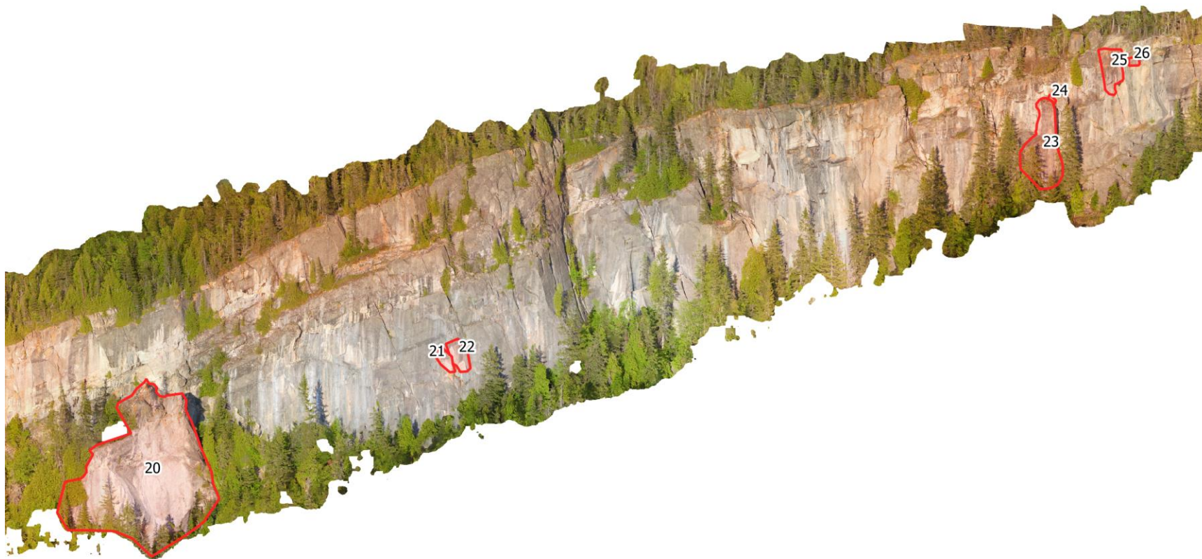
Figure 33. Vue d'ensemble de la paroi secteur ouest et identification des blocs potentiellement instables # 20 à 26
