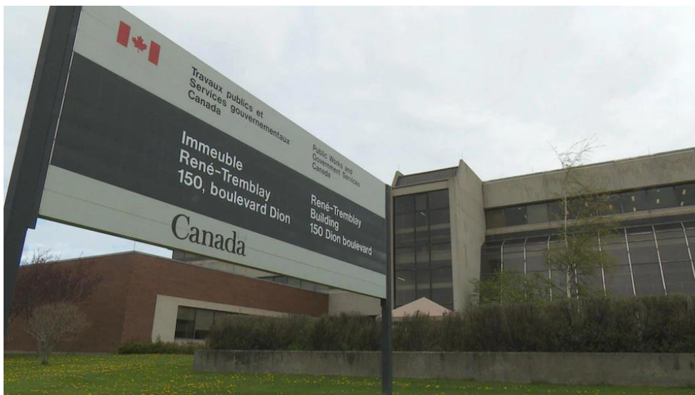
Figure 1. Façade de l'immeuble René-Tremblay servant présentement de bureaux pour la DIORG
