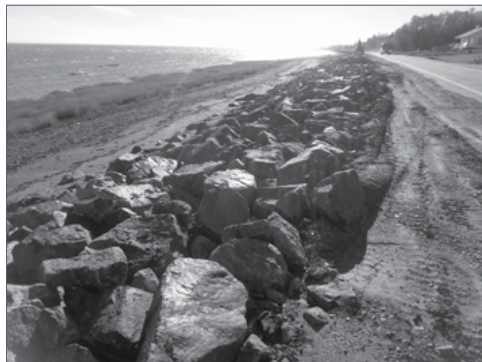
La structure de protection de type enrochement, secteur sud de l'île. Crédit photo : Francis Bonnier Roy
