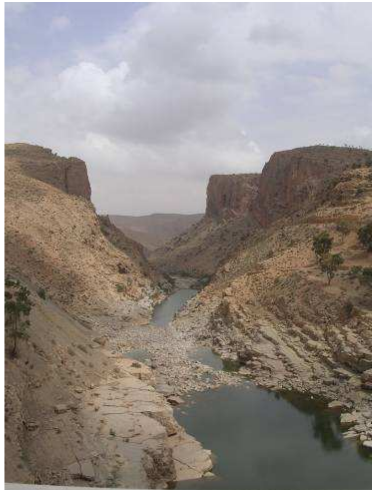
Figure 5 : Gorges de la Moulouya, aval du barrage Mechra Homadi
