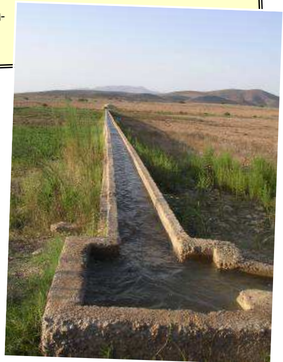
Canal d'irrigation, plaine des Triffas, Maroc
