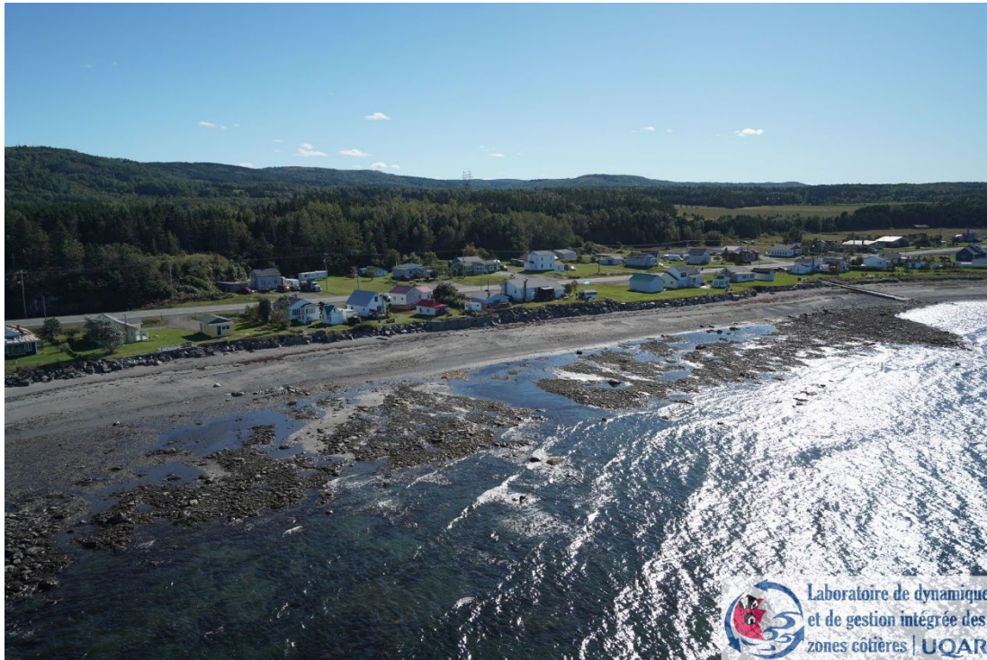
Figure 23 : Enrochements à l'Anse-à-la-Croix. Source : LDGIZC (SigecWeb)
