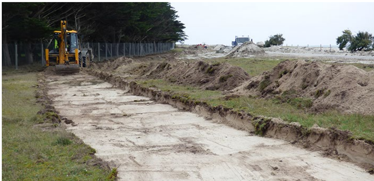
Figure 18 : Travaux à la Plage du Ster, Penmarc'h. Source : https://www.penmarch.fr/erosion-dunaire-au-ster-les-travaux-ont-demarre
