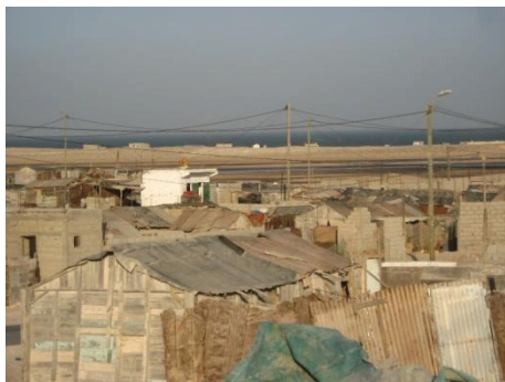
Figure 22- Quartier Tarhil en bordure de la rivière à Spartines, Au fond, les cabanons et la baie du Lévrier.
