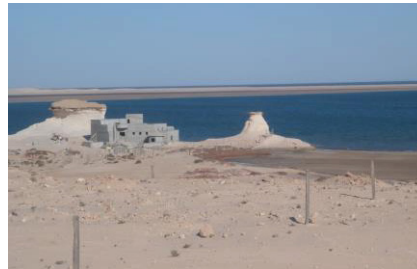
Figure 20 - Construction abandonnée au pied des champignons.
