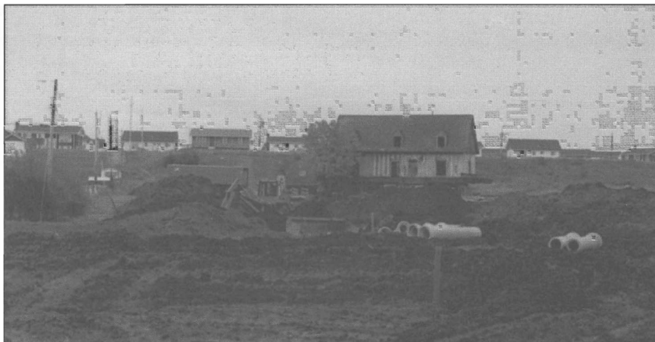
Les travaux de restauration en date du 6 octobre 1980.
