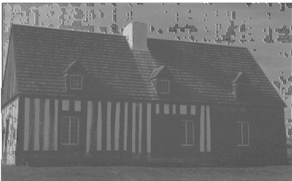
La maison Lamontagne après la restauration (façade sud)
