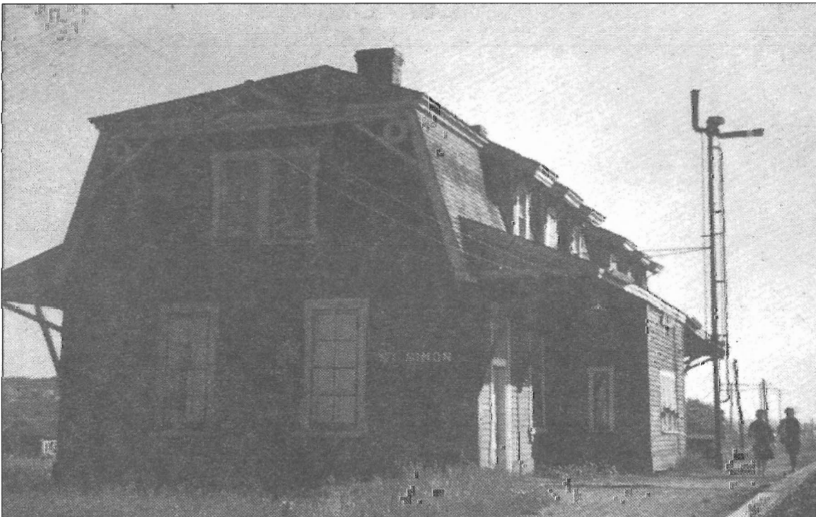
Gare de St-Simon (source : Pour les 150 ans de St-Simon , p. 159).
