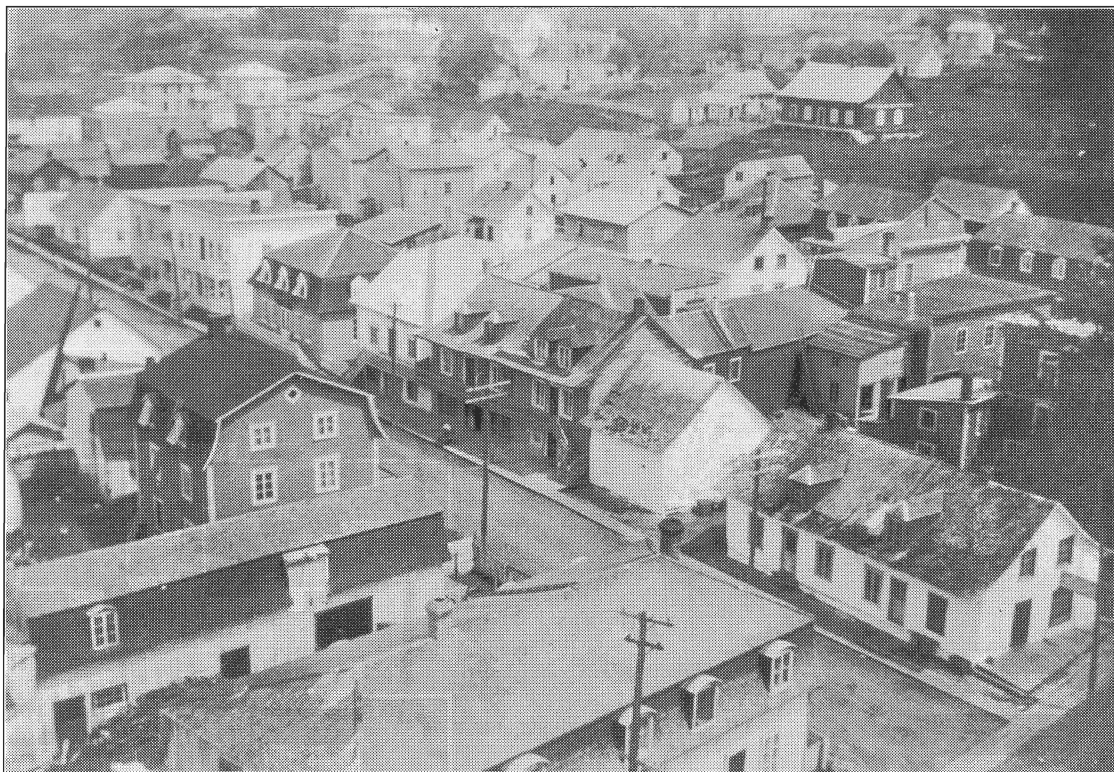
Rue Saint-Paul au début du siècle (collection de la Fabrique Saint-Germain-de-Rimouski).
