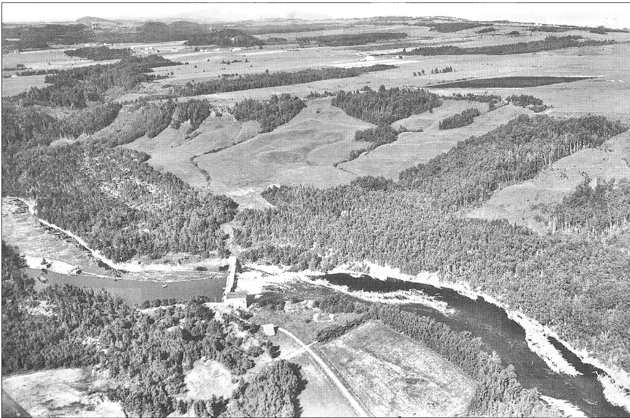
Figure 6. Le barrage de la Compagnie de Pouvoir électrique de Rimouski, à 3,5 km de l'embouchure, exploite une faible dénivellation du lit de la rivière qui touche le socle rocheux. Au centre : les glissements d'argile anciens. Photo : ANQ : fonds de la Compagnie aérienne franco-canadienne, c. 1927.
