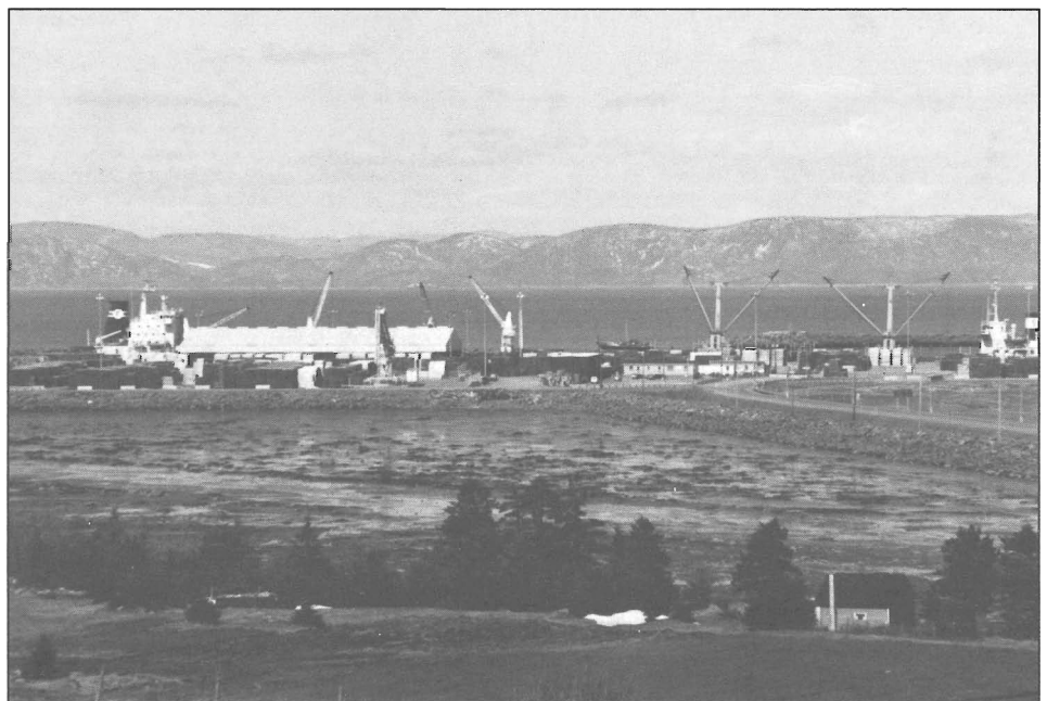
Une partie des installations du port de Gros-Cacouna.
