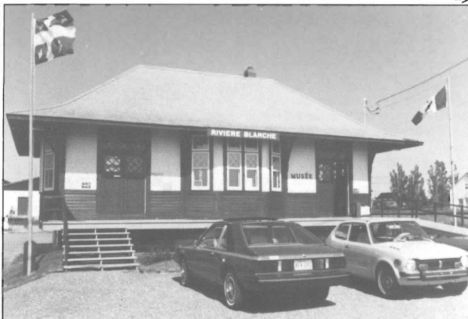
Le Musée après la restauration (1983)
