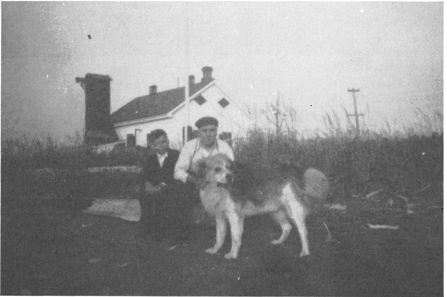
Le hangar du signal de brume et le cornet au sommet d'une petite tour, selon le montage des années '30 (Collection Centenaire de Pointe-au-Père).
