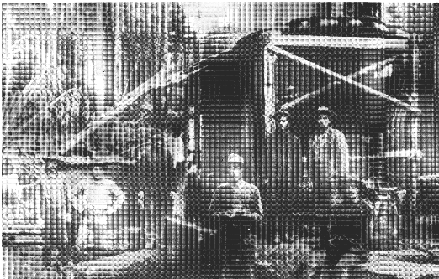
Construction du chemin de fer. 1877.
