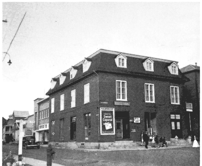
Photo du premier magasin Lepage. En arrière un agrandissement construit plus tard.
