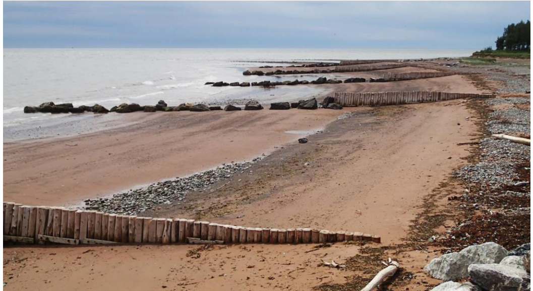
Figure 9 : Photographie montrant le type de structures de protection en épis construites sur la plage de la flèche littorale de Hope Town, baie des Chaleurs (©Zélie Schuhmacher).
