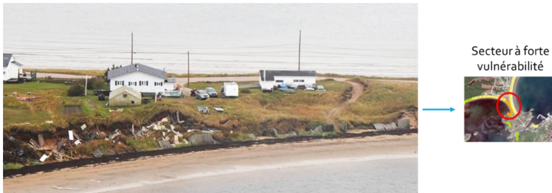
Figure 50: Exemple de déchets et d'ouvrage de protection côtière mal adapté, segment KEG-005, Kegaska, (LDGIZC, 2019)
