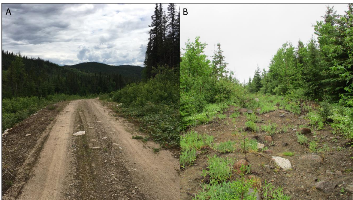
Figure 0.1 : Illustration de l'état de la végétation recolonisant passivement l'assise d'un chemin forestier de 10 ans (A; crédit photo : Fabien St-Pierre) par rapport à un chemin forestier de 4 ans ayant fait l'objet d'efforts de restauration active (B; crédit photo : Rebecca Lacerte)
