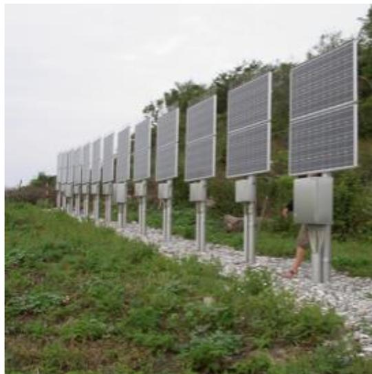
Figure 11. Panneaux PV orientés verticalement
