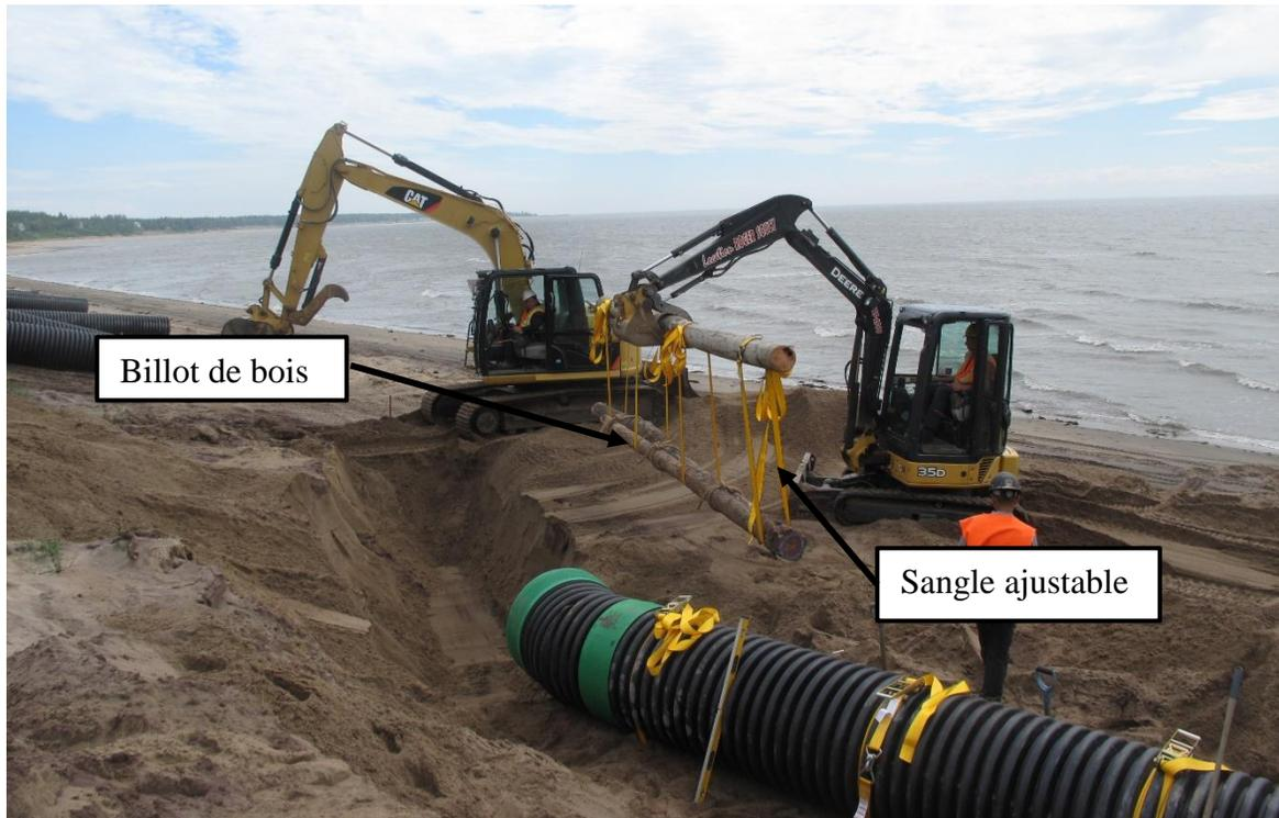
**Figure 9. Mise en place de l'ancrage des Rolodunes**
