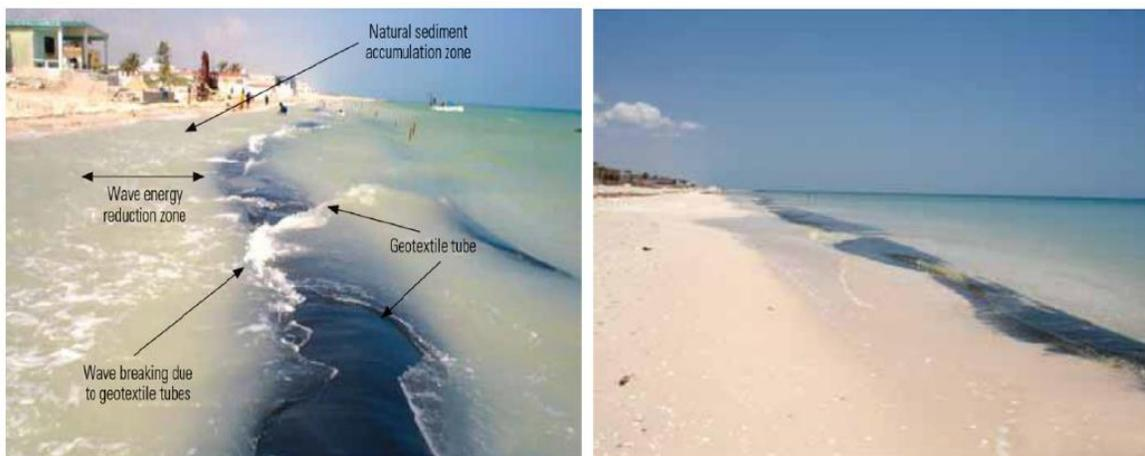
**Figure 5. Exemple d'un tube géotextile de protection côtière (Alvarez et al., 2007 dans Oyegbile et Oyegbile, 2017)**
