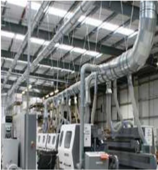
Figure 6 Système de dépoussiérage interne [4]
