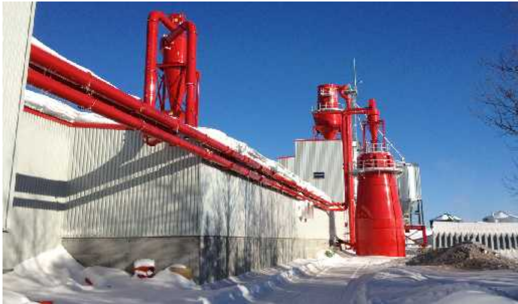
Figure 4 Exemple de système de transport pneumatique industriel [2]
