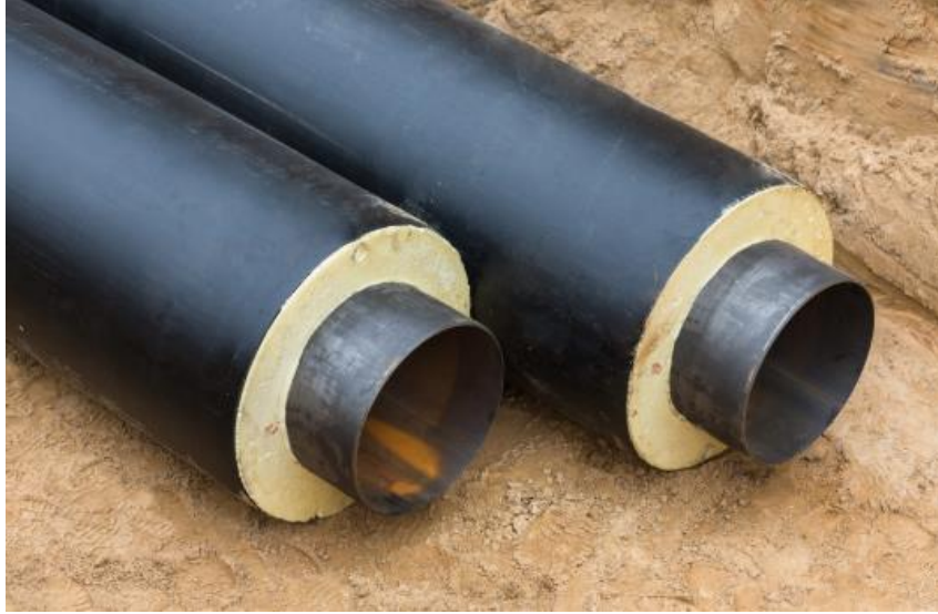
Figure 26: Tuyaux des conduites principales du réseau de chauffage
