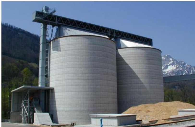
Figure 7 : Silo de stockage de biomasse en béton
