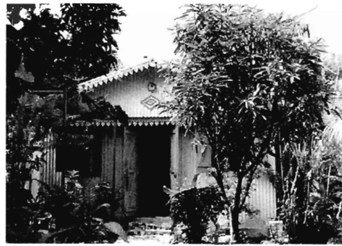
Figure 25 : Case en bois sous tôle
