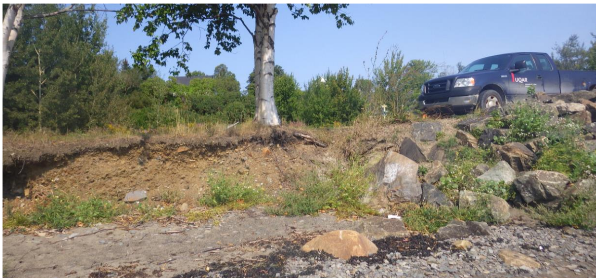
Figure 157. Érosion accentuée (effet de bout) par un enrochement déjà présent avant cette étude à l'est du profil 2 (distance 3 000 m), sur la côte sud de l'île le 1 er septembre 2015.
