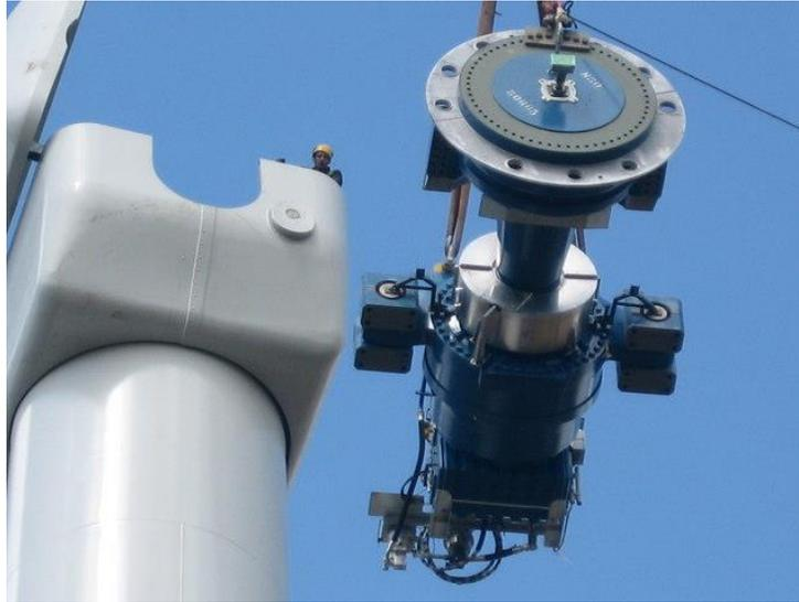
Figure 4:Frein mécanique d'une éolienne
