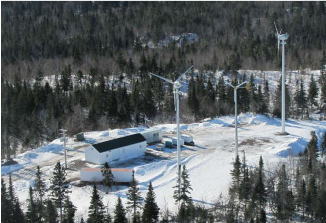
Figure 1.3: Photo du micro réseau réalisé au TechnoCentre Éolien [46]
