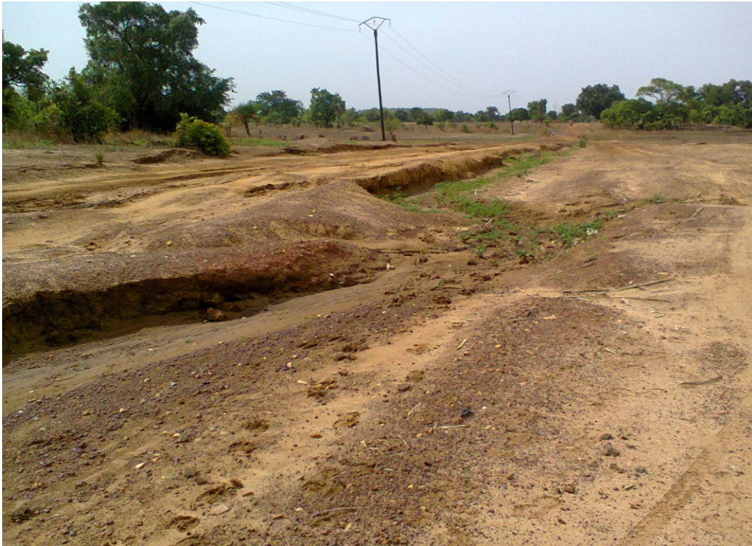
Photo n°01 : Vue de la route principale menant à Founougo, commune de Banikoara
