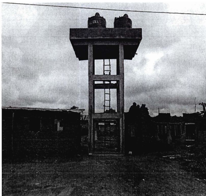
Figure 15 : Poste d'Eau Autonome privé à Tchaourou Source : Rafiou Bah-Agba, août 2013.
