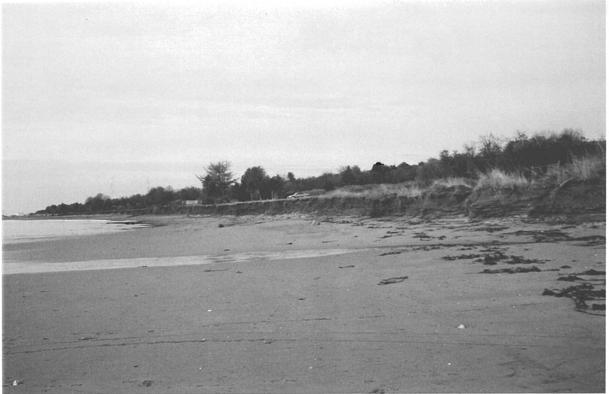
Figure 54 : Érosion de la falaise située à l'ouest de l'épis rocheux
