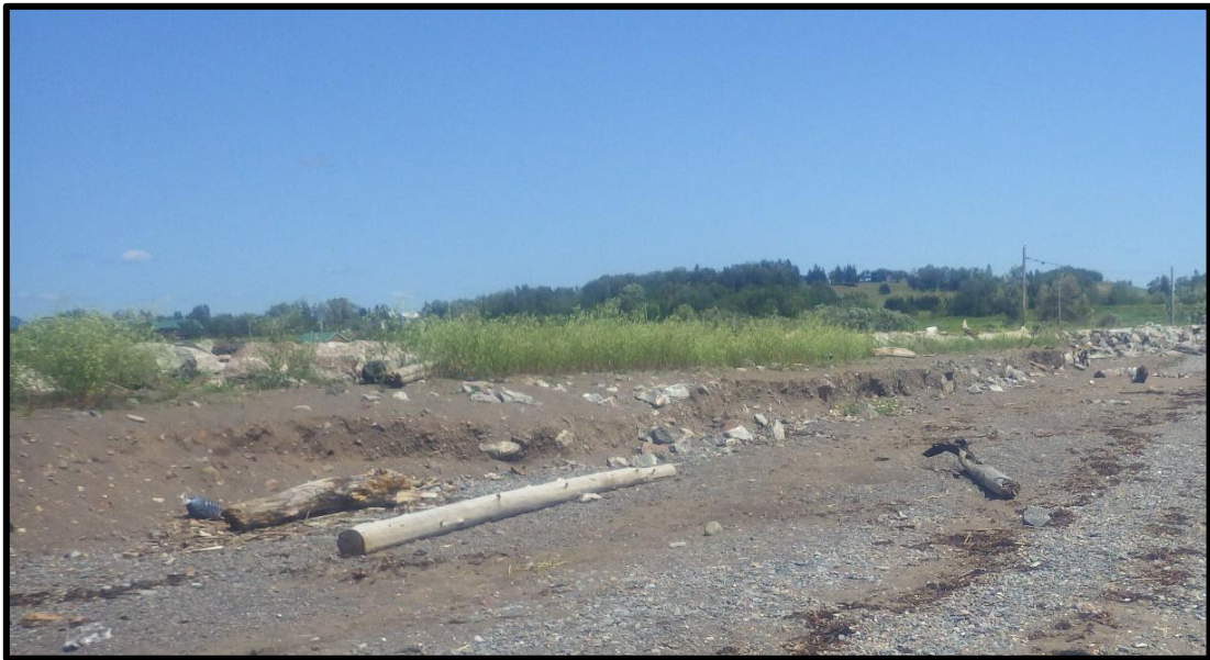
Figure 85. Recharge du banc Larocque en août 2019. Une microfalaise se dessine sur l'ensemble de la recharge.
