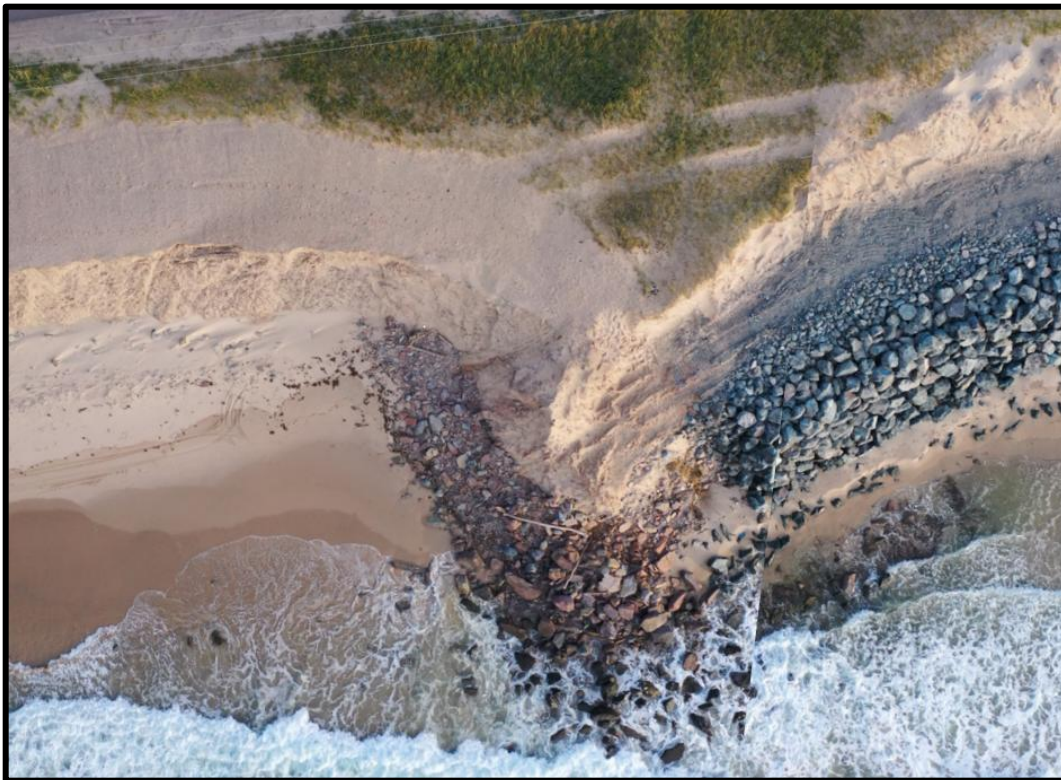
Figure 148. Secteur de la recharge en 2019 : au sud l'enrochement et au nord la recharge.
