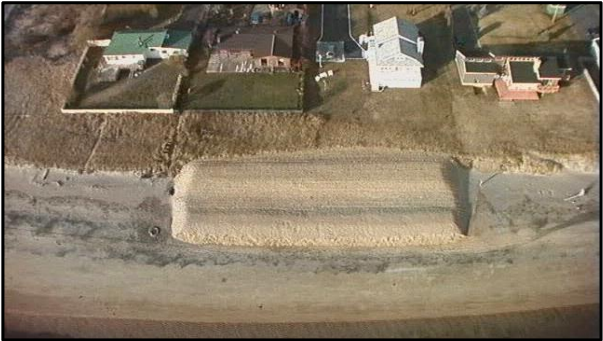
Figure 106. Photo oblique de la recharge en 2000, après la mise en place de la recharge.
