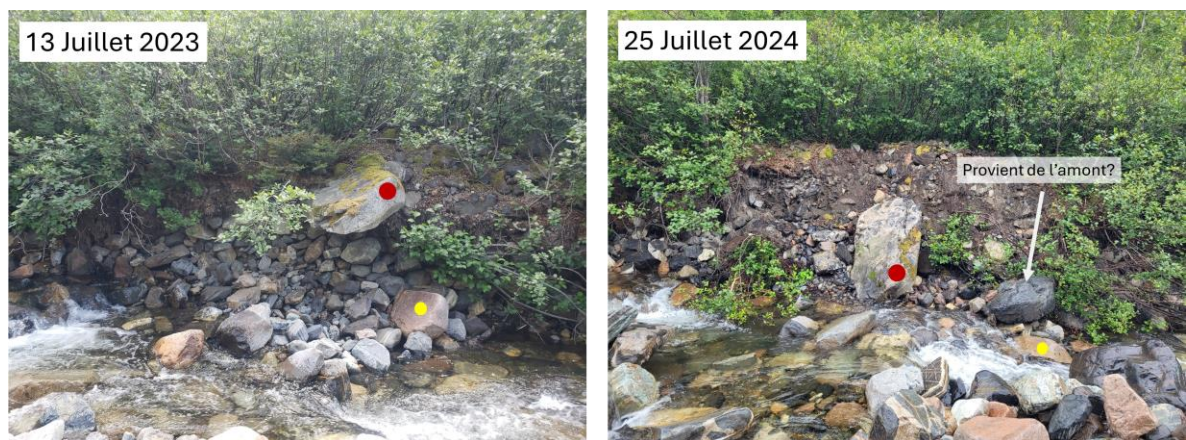
Figure 8. Érosion d'une berge et déplacement de blocs dans le ruisseau des Portes de l'Enfer.
