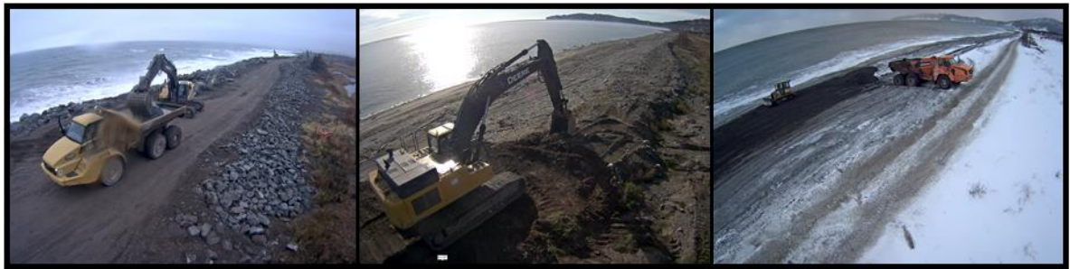
Figure 45. Exemple d'interventions sur le site d'étude de Cap-des-Rosiers. La première photo représente des travaux de démantèlement le 28 octobre 2016. La deuxième photo représente un reprofilage du cordon le 13 octobre 2017. La troisième photo présente une recharge de plage le 12 décembre 2018. (Source photos : LDGIZC)
