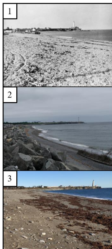
Figure 33. Évolution de la largeur de plage en 1927, 2011 et 2019 soit, respectivement, avant la construction de la route, suivant la mise en place d'infrastructures de protection et après le démantèlement de la route et de ses infrastructures. (Source photo 1 : J.-Gérard Lacombe , Source photo 2 et 3 : LDGIZC)
