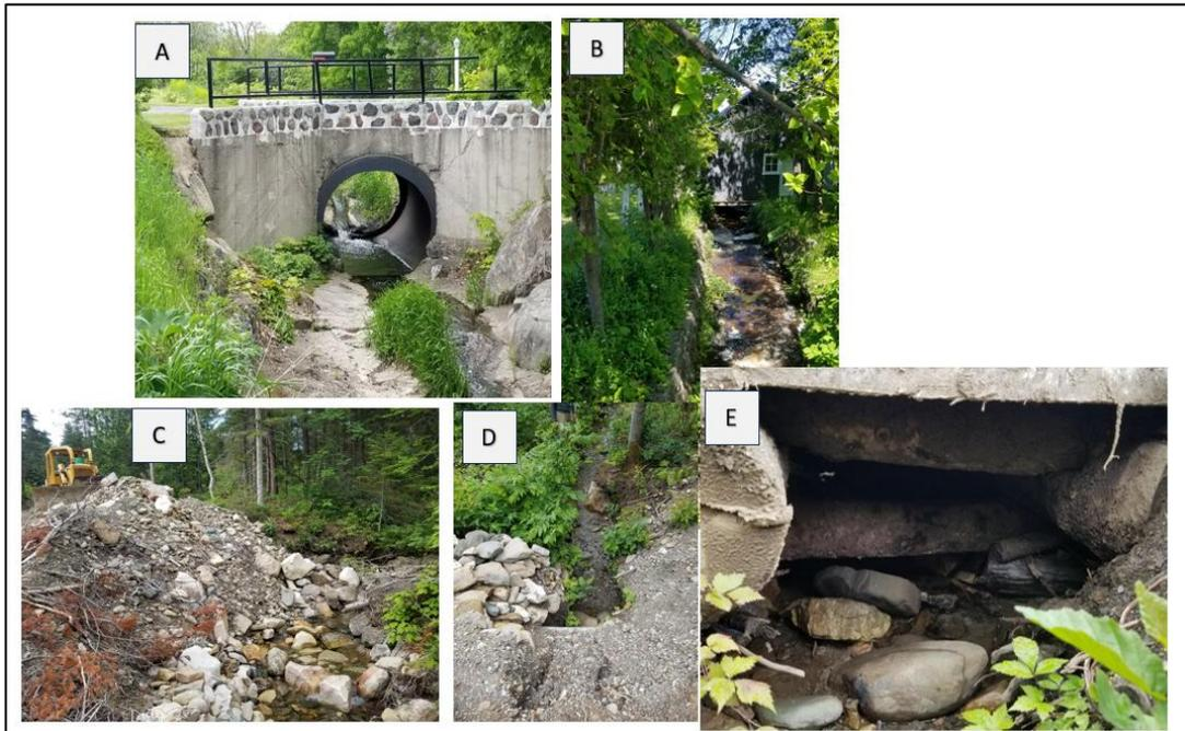
Figure 41. Photographie des facteurs aggravants anthropiques observés sur site. A : Artificialisation du cours d'eau, B : Construction de cabanon sur les berges d'un cours d'eau, C, D et E : Obstruction sédimentaire du ponceau par l'activité humaine
