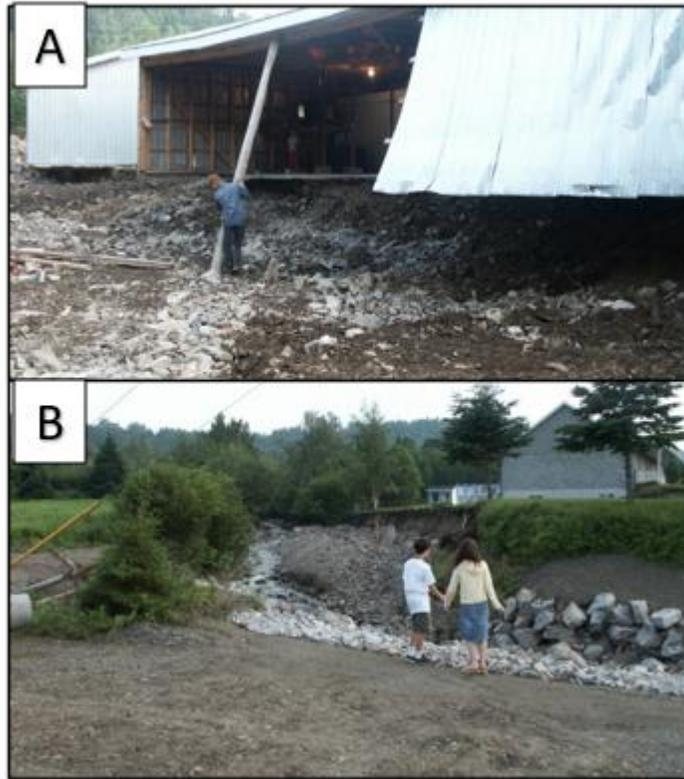
Figure 12. A : Fondation d'entreprise de pêche détruite. B : Dépôt important de sédiments dans le ruisseau Côté près de la route 132 à Rimouski. Perte de terrain par le recul de la berge. © Buffin-Bélanger et Héту, 2008.
