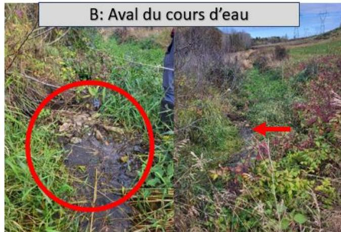
Figure 44. Photographie des indices d'accumulation en aval du cours d'eau, zone d'immersion du ponceau.
