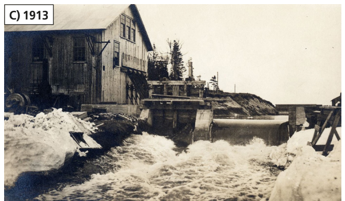
Figure 3. Photographies historiques du canal Saint-Georges A) vu vers l'amont, au niveau du coude (350 m), quelques années après sa construction; B) vu vers l'aval, au niveau du coude (350 m), lors de la construction du muret de stabilisation des berges; C) devant la scierie alimentée par le barrage X2092719 démantelé (475 m).
