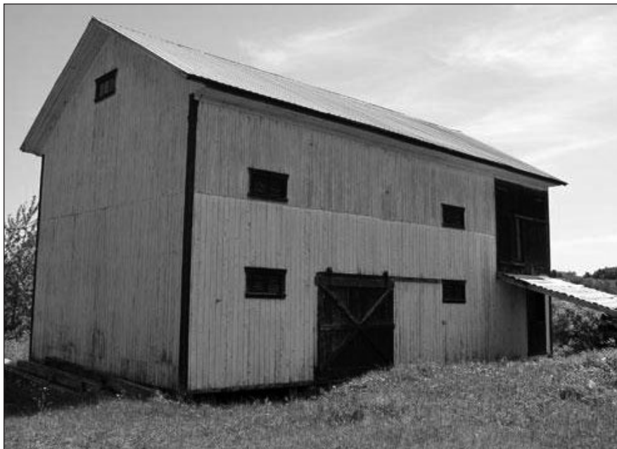
Figure 4. Grange de la meunerie.
