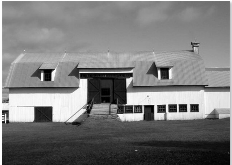
Figure 3. Grange principale de la ferme Massé.
