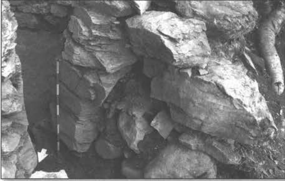
Figure 9 : Gueule du four à chaux, parement nord-est, vue vers le sud-ouest
