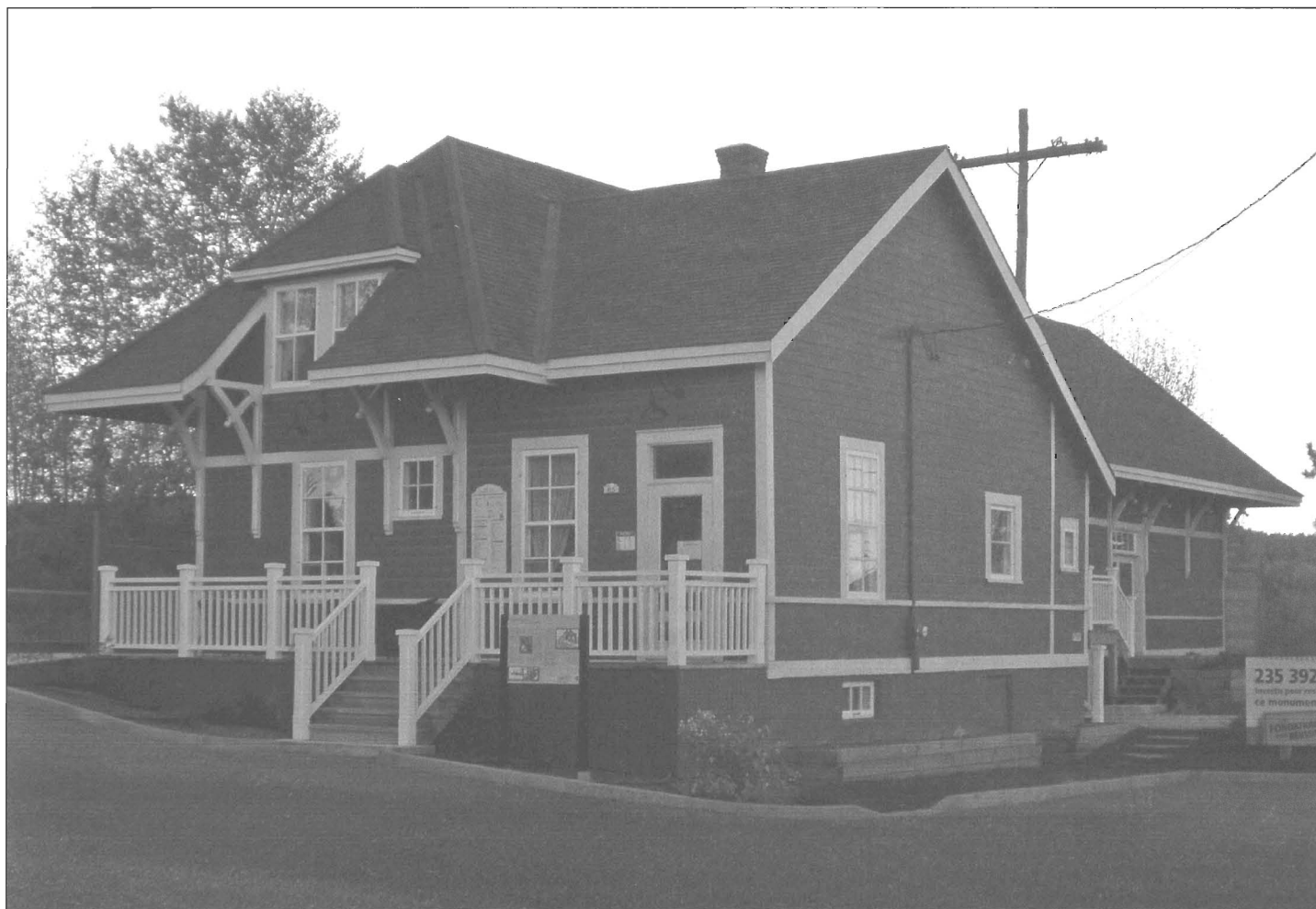
Gare restaurée de Rivière-Bleue - Transcontinental Railway (Droits de la photo : Corporation du patrimoine de Rivière-Bleue)
