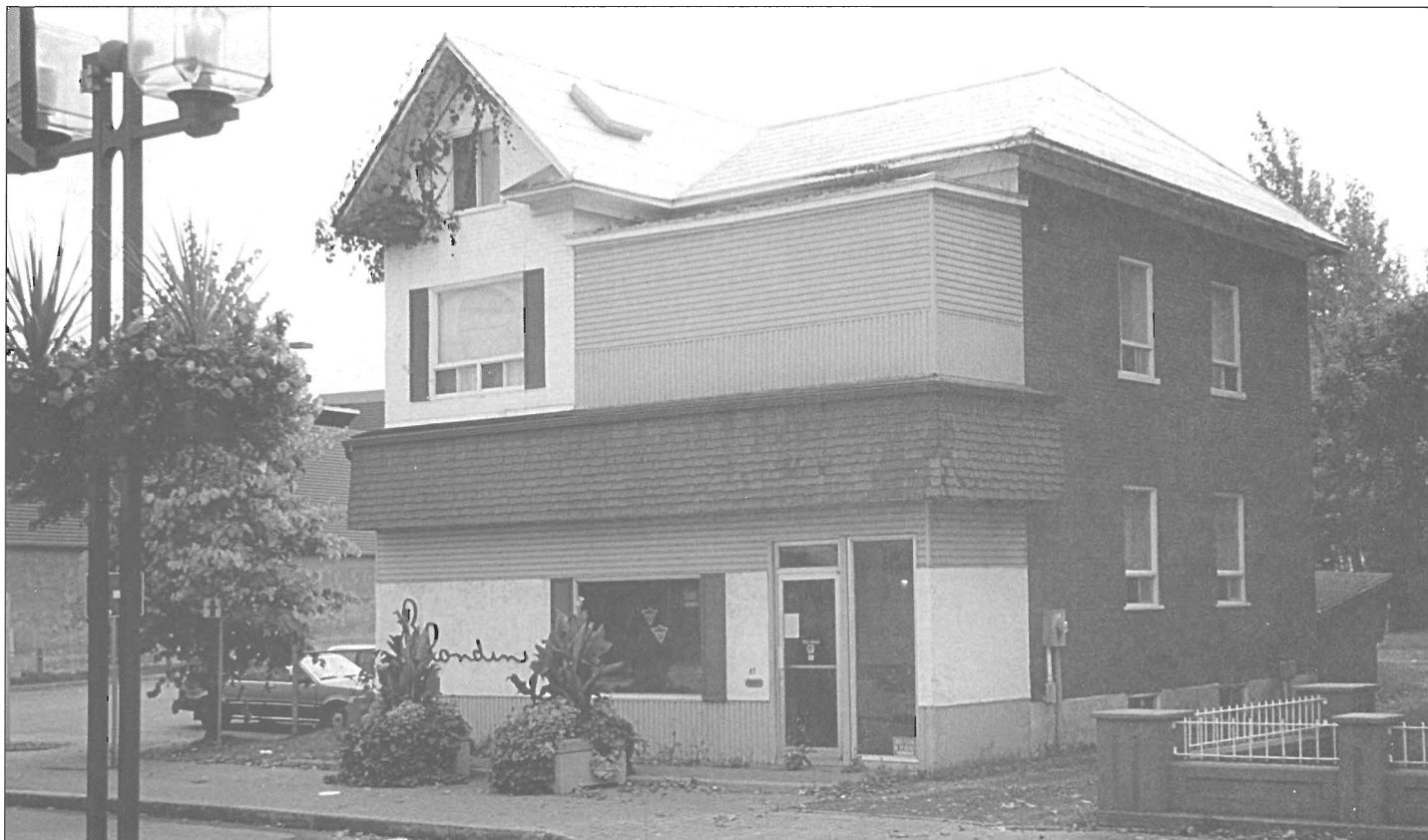
Vue extérieure du troisième studio. (Photo Blondin Lagacé, 1970)
