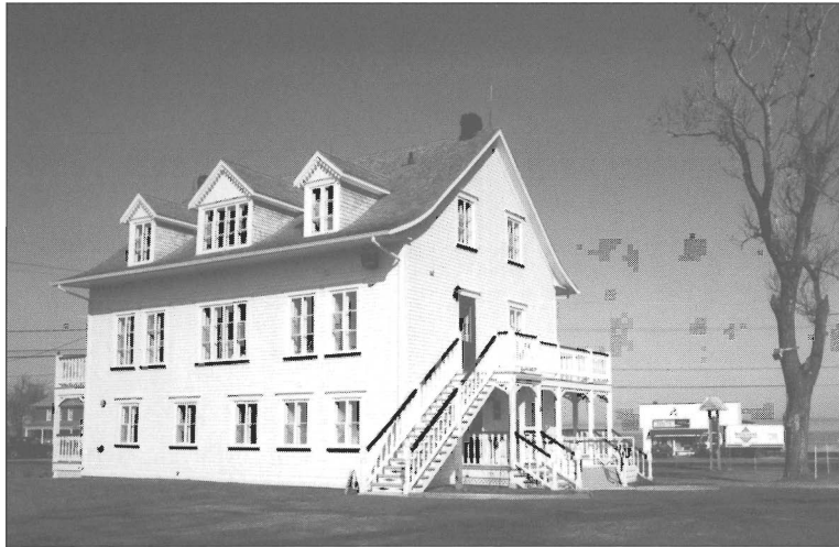
Le vieux presbytère de Saint-Flavie transformé en Centre culturel (Jean Larrivée, 1994)
