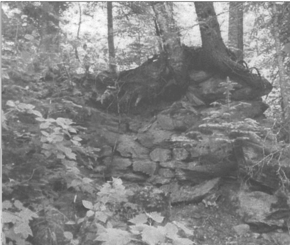
Four à chaux, vue d'ensemble avec la présence d'arbres matures sur le rebord du mur arrière. Menace éventuelle d'écroulement.
