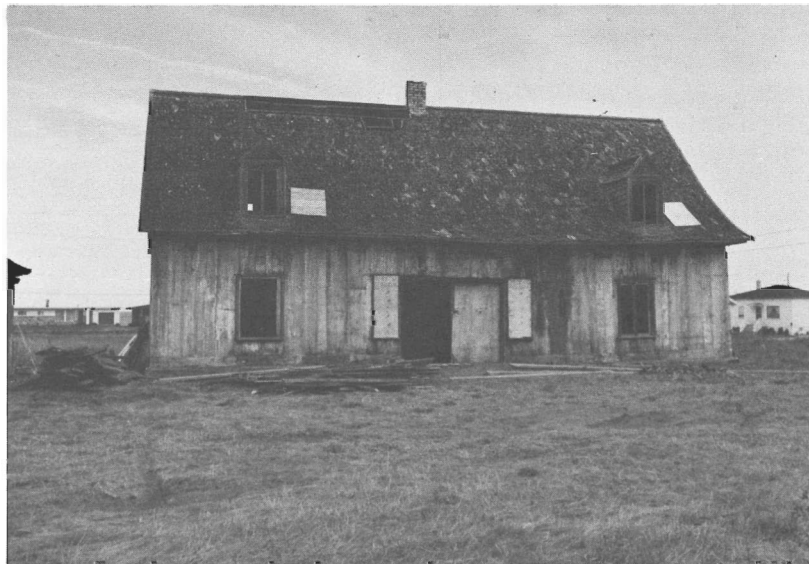
En cours de curetage (MAC).
