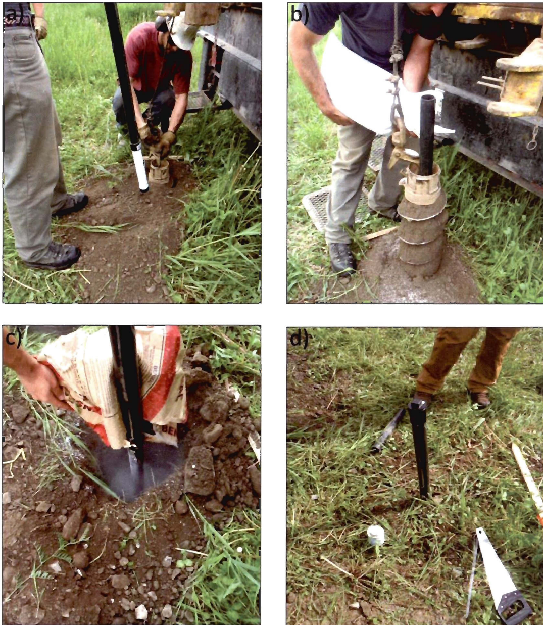
Figure 2.13 Mise en place d'un piézomètre. a) insertion du piézomètre à l'intérieur de la mèche de la foreuse b) mise du sable de silice autour de la crépine c) mise en place du bouchon étanche (bentonite) d) piézomètre produit fini.
