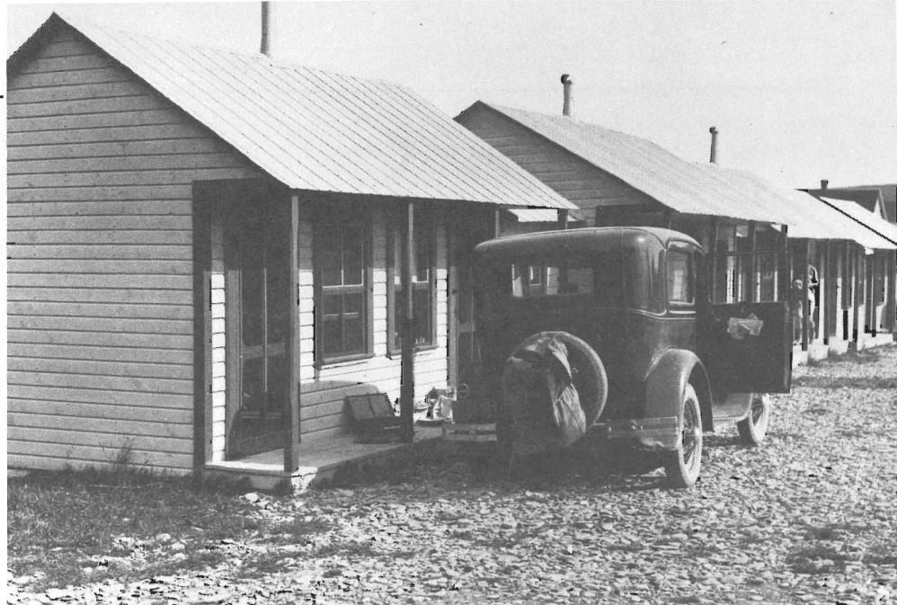
Les fameuses «cabines» qui sillonnaient tout le parcours du Bas St-Laurent et de la Gaspésie. (Archives publiques du Canada, PA146173).
