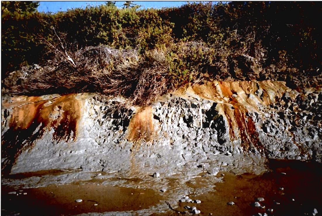
Figure 5.23. Érosion différentielle tribulaire de l'écoulement d'eau sur la surface de la paroi à proximité de la station 2.
