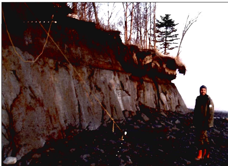
Figure 4.7. Position de la tige en partie prise dans le silt marin sur l'estran à la suite de la dislocation du pied de glace à la station 1 le 30 mars 2006.
