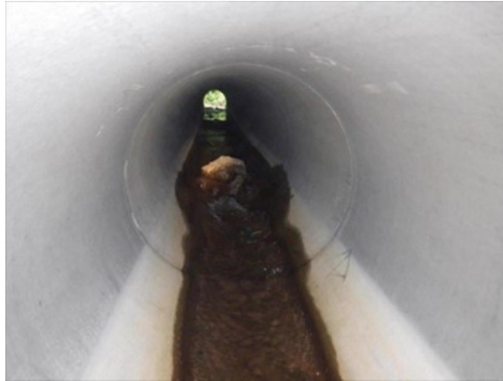
Figure 25 : Vue vers l'intérieur du ponceau du ruisseau PEN D et sur l'accumulation de galets à mi-chemin de la structure (crédit photo : Tchakondo et Villeneuve, 2013)
