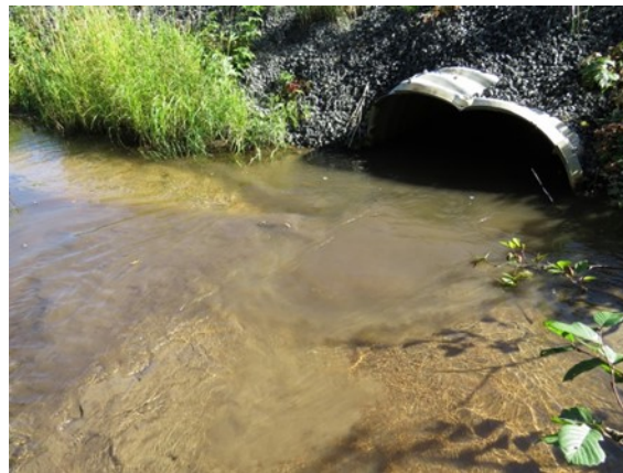
Figure 20 : Ensablement du ponceau à la confluence entre le cours d'eau forestier et le fossé routier formant le ruisseau PEN B1 (crédit photo : Caron, 2013)
