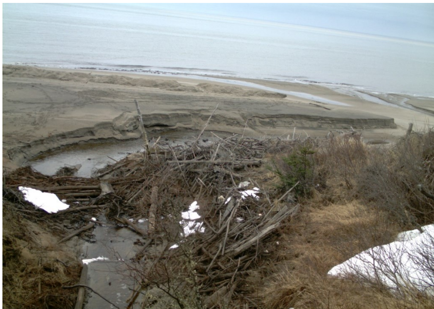
Figure 29 : Vue sur l'embouchure du ruisseau LPM D lors d'un épisode de fort débit (crédit photo : Caron, 2013)
