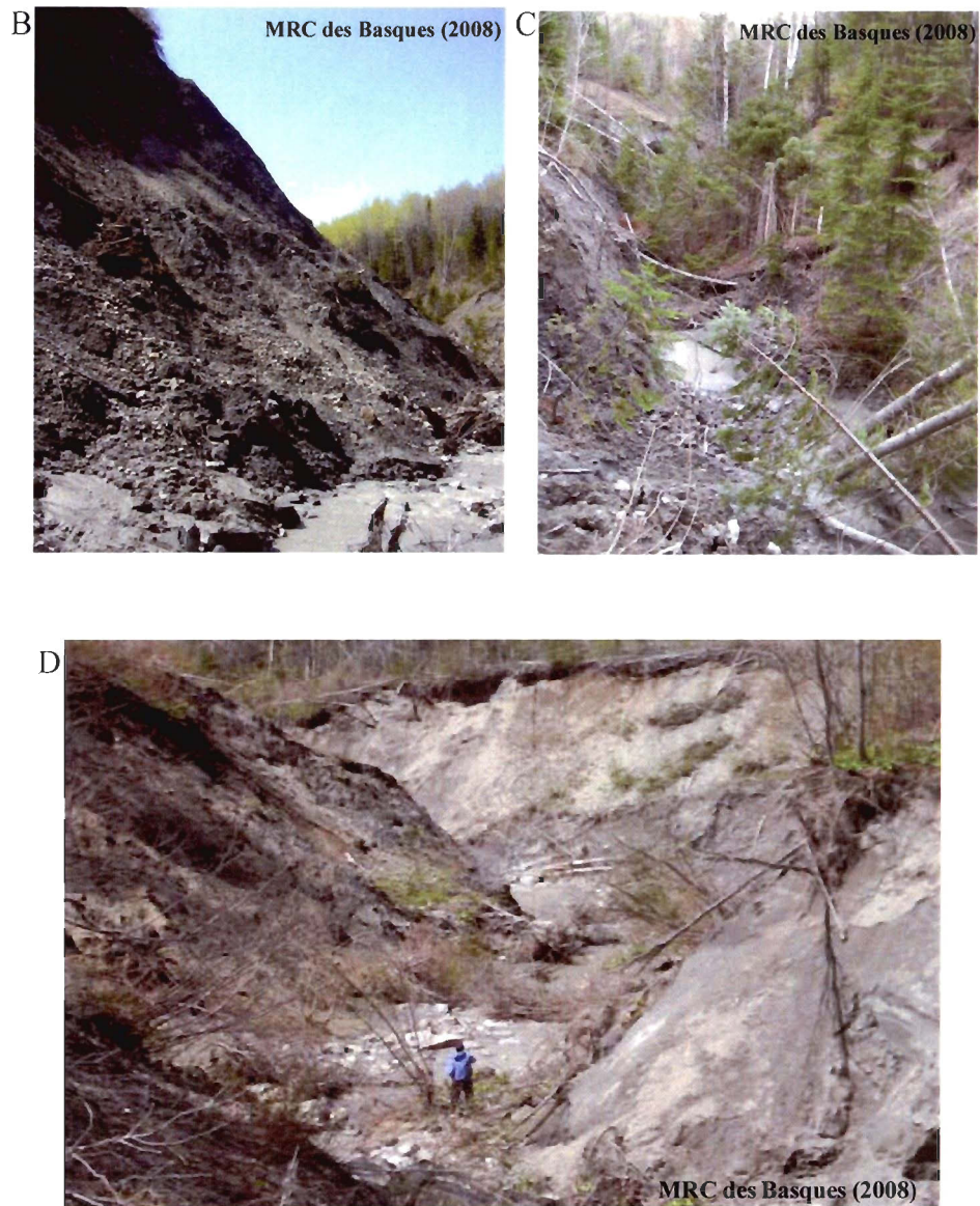
Figure 3.4 Photos illustrant la forte incision (A), l'érosion des berges et les coulées boueuses (B), les arbres accumulés dans le lit (C, D) du cours d'eau Bonhomme-Morency à l'année 2008.
