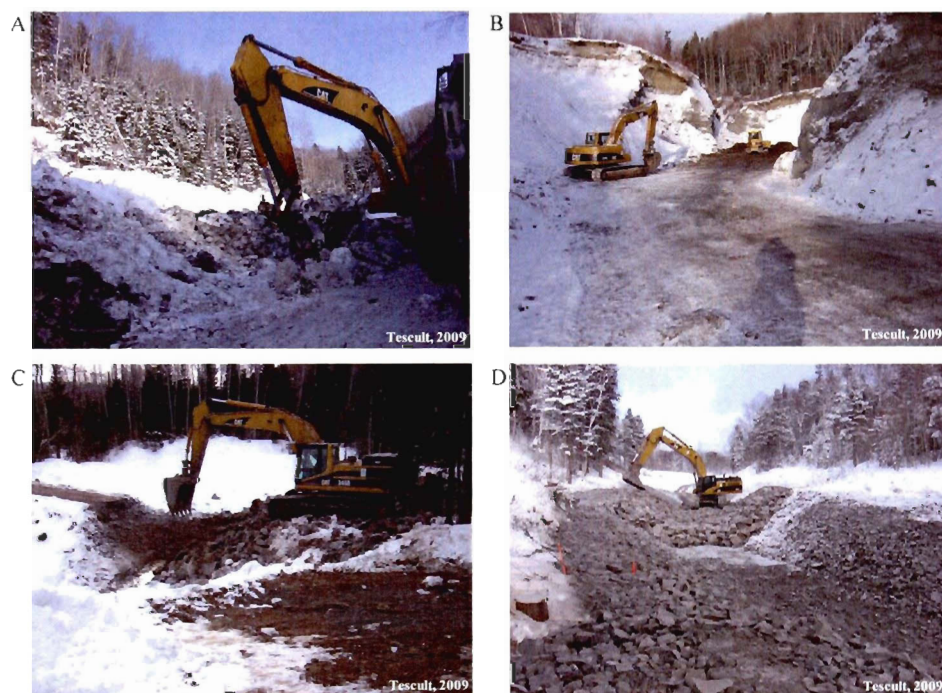
Figure 3.7 Photos des différentes étapes des travaux d'énrochement du cours d'eau Bonhomme-Morency : nettoyage du lit et des berges (A), couche de tout-venant (B), excavation du lit (C) et couche de protection (D).
