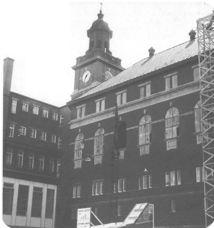
Travaux extérieurs pour la bibliothèque (Service de gestion documentaire et des archives du Cégep de Rimouski)
