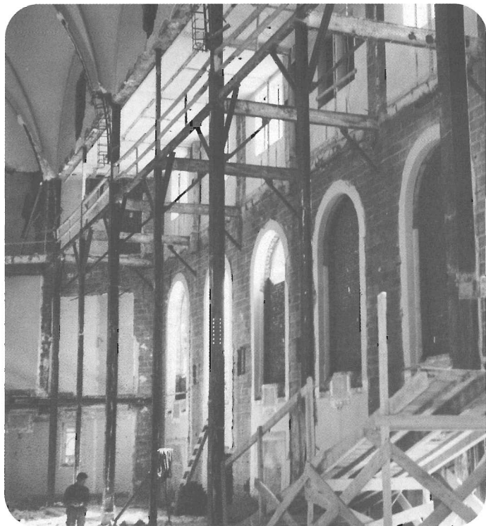
Travaux de charpente pour la bibliothèque (Service de gestion documentaire et des archives du Cégep de Rimouski)
